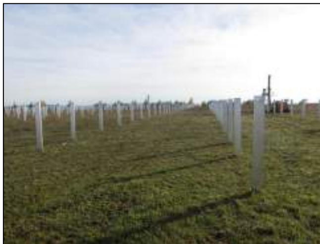
Illustration 58 : Exemple de pieux battus dans le sol avec une batteuse visible en arrière-plan
